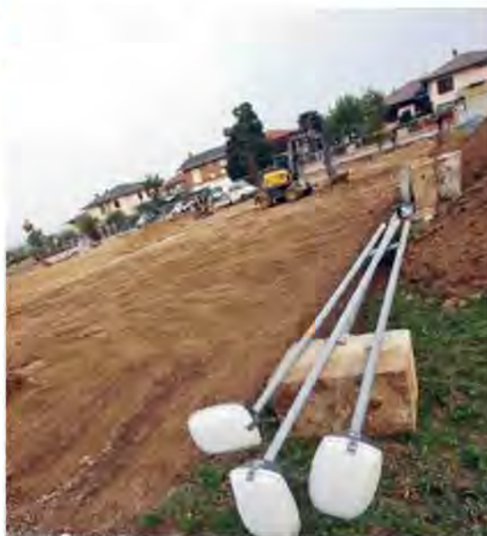
Il cantiere di via Pio X per il parco inclusivo. FOTO DONOVAN CISCATO
