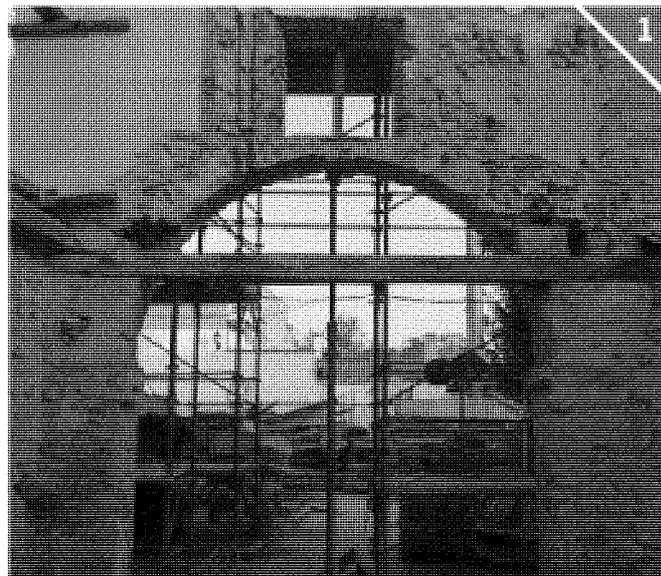
Uno degli archi riemersi dopo la demolizione dell'intonaco
