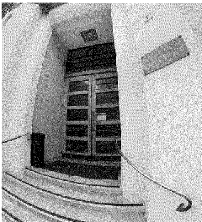
La casa di riposo della fondazione Marzotto a Valdagno. STELLA-CISCATO
